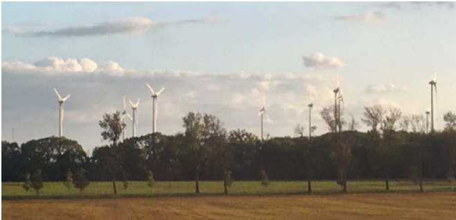
Abb. 24 Windenergieanlagen – die Rotorblätter aus FVK sind geklebt 30
