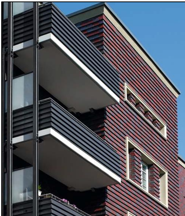
Abbildung 27 Gestaltung mit Klinkerbelag
