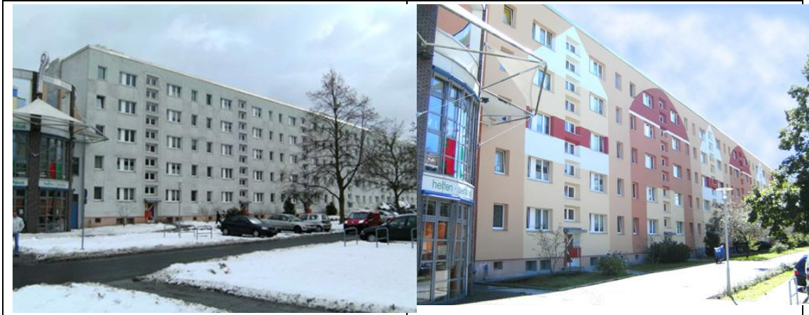
Abbildung 23 Neugestaltung eines Plattenbaus in Berlin-Henningsdorf
